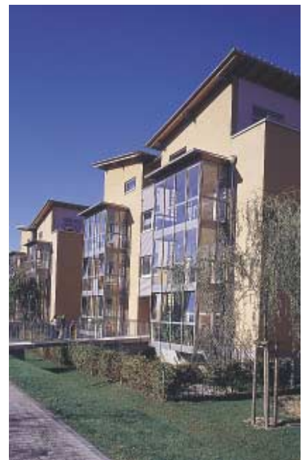
Gepflasterte, stufenlose Verbindungswege zwischen den Wohneinheiten machen Besuche und Spaziergänge leicht. Köln-Holweide, Oberiddelsfeld
