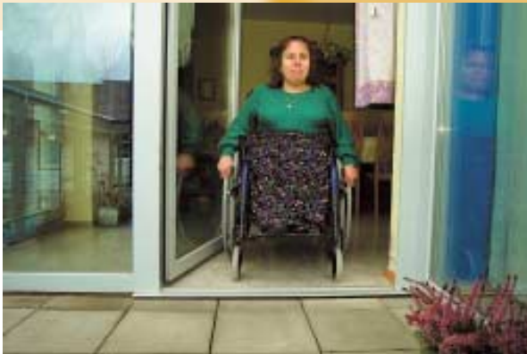
Konstruktion eines schwellenlosen Balkonaustritts. Brunnenstr., Schwelm
