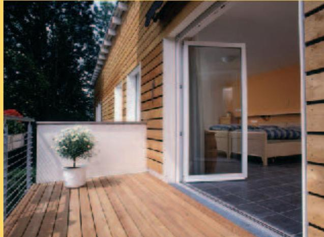
Durch einen Holzrost, der über der wasserführenden Schicht liegt, und die Wahl von Öffnungselementen mit bodenbündigem Anschlag lassen sich auch im Bestand Balkon- und Terrassenzugänge barrierefrei anpassen.
