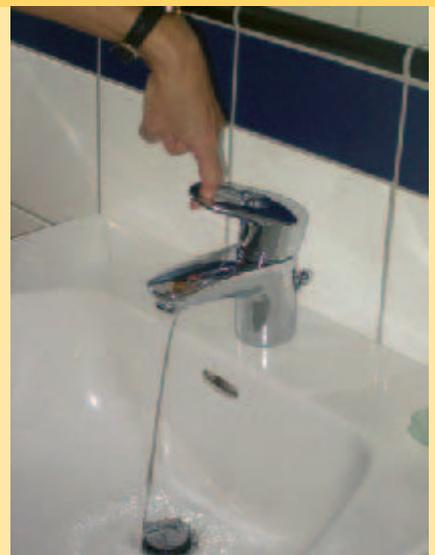
Bei der Renovierung lassen sich kostenneutral griffsichere Armaturen einbauen, zum Beispiel mit einem Griffloch oder mit einem verlängerten Griff, der auch mit dem Ellenbogen bedient werden kann.
