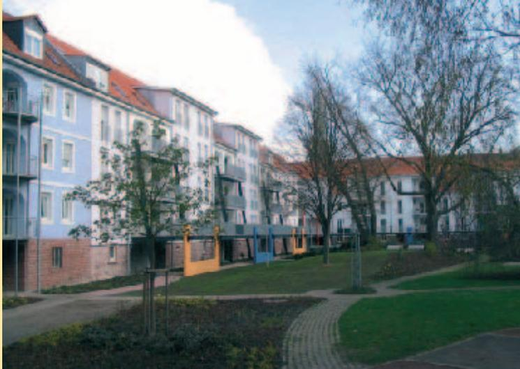
Über einen Laubengang sind die erhöht liegenden Erdgeschosswohnungen mehrerer Hauseinheiten barrierefrei zu erreichen. Der zugehörige Aufzug bedient außerdem alle Geschosse eines weiteren Gebäudes. Alternativ sind Hublifte zum Balkon möglich oder – preiswerter, wartungsfrei und weniger auffällig – durch Höhenmodellierung in die Freianlage integrierte Rampen.
