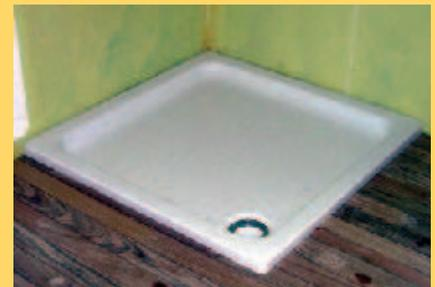
Wenn eine bodengleiche Dusche konstruktiv wegen der erforderlichen Aufbauhöhen nicht möglich ist, bietet eine flache Duschwanne erleichterten Zugang.
