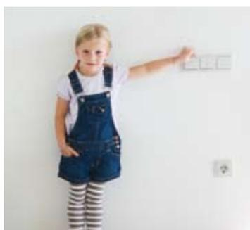
Lichtschalter so montieren, dass alle in der Familie sie bedienen können, auch die Steckdose in gut erreichbarer Höhe von 50 cm anbringen.
