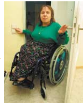
Lichtschalter und Türgriffe in 85 cm Greifhöhe, wichtige Details für die Wohnqualität, die keine Mehrkosten verursachen. Brunnenstr. Schwelm
