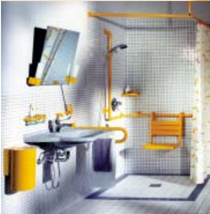
Durchgeflieste bodengleiche Dusche mit Sitz und Haltegriffen.
