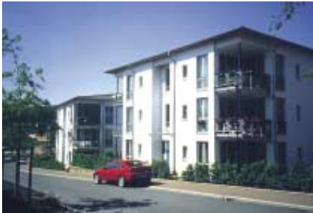
Sämtliche Wohnungen der Stadtvillen sind mit einem Balkon oder einer Terrasse ausgestattet.
