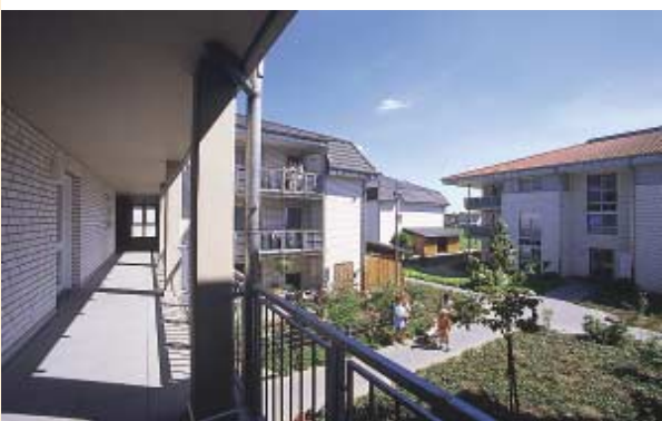
Laubengänge sind im barrierefreien Wohnungsbau die beliebteste Erschließungsform. Parkstr., Willich
